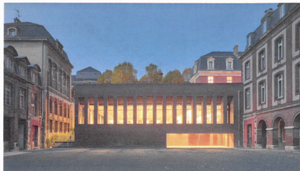
Extension- du lycée Corneille - Rouen - ACAU Architectes
